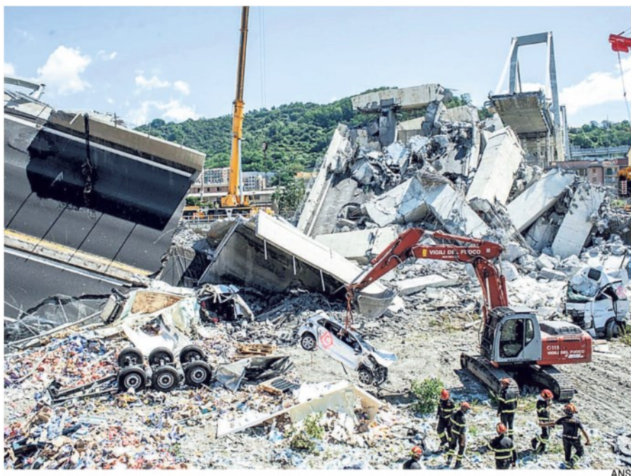
Genova: quel che resta del ponte Morandi, crollato tre anni fa
