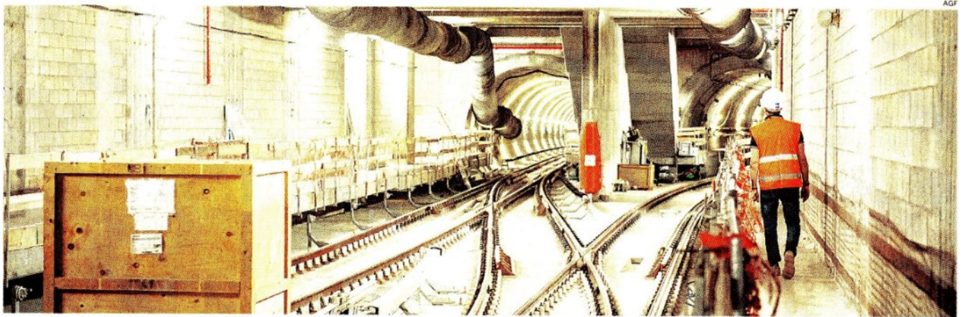
Lavori in corso. Un cantiere della metro blu all'aeroporto di Linate
