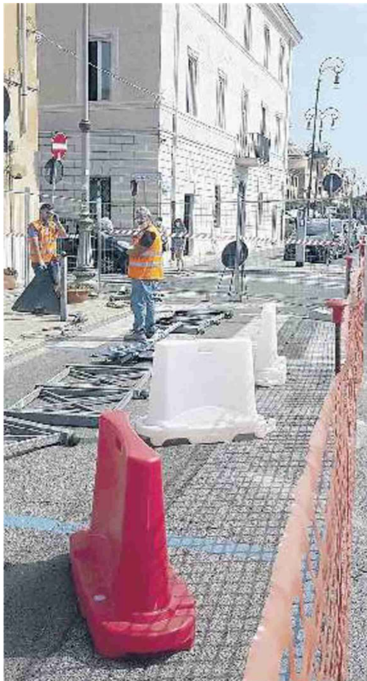
Lavori di rifacimento di una strada nel Comune di Fiumicino
