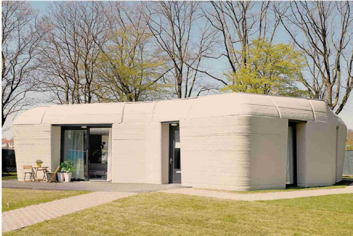
Project Milestone. La prima casa in 3D realmente abitata in Olanda, a Eindhoven
