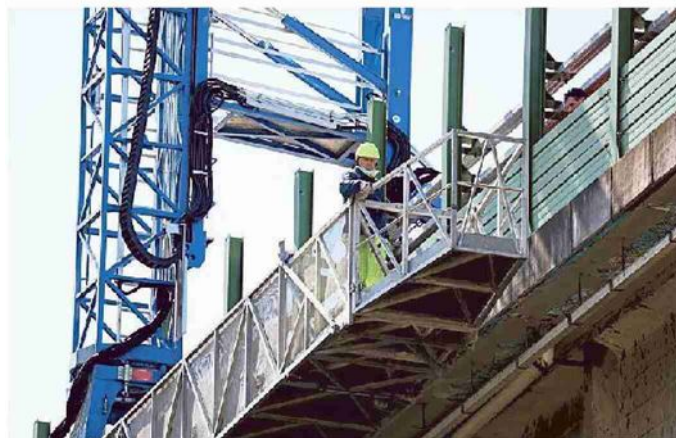
I controlli su viadotto Valle Ragone, a Sestri Levante
