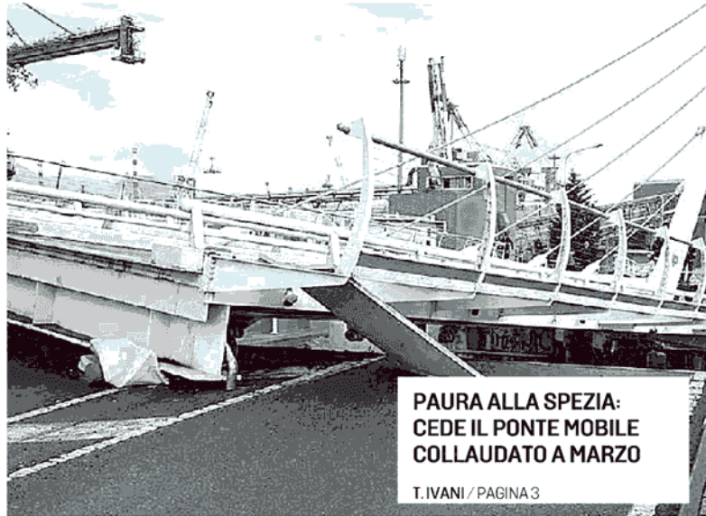
La Spezia, il ponte mobile di Pagliari dopo il cedimento di un pistone idraulico
