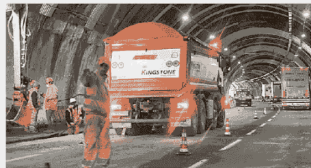
Un restringimento per cantieri in Autostrada
