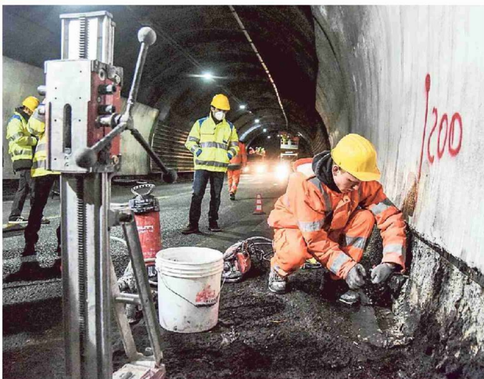
Lavori di manutenzione e controllo su un'autostrada ligure
