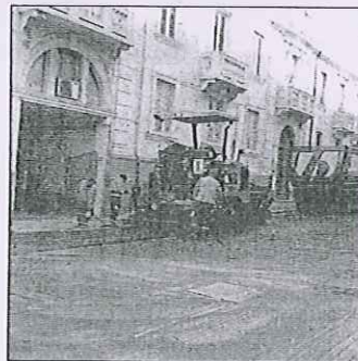
Alcuni lavori di scarifica in via Tommaso Campanella
