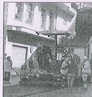
Operai in campo per via Campanella
