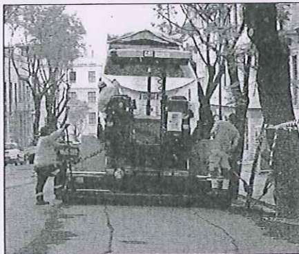
I lavori in via Romeo
