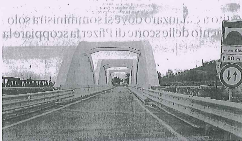
Transito alternato Uno dei ponti degli anni '30 che penalizzano la fluidità della circolazione sulla "106"
