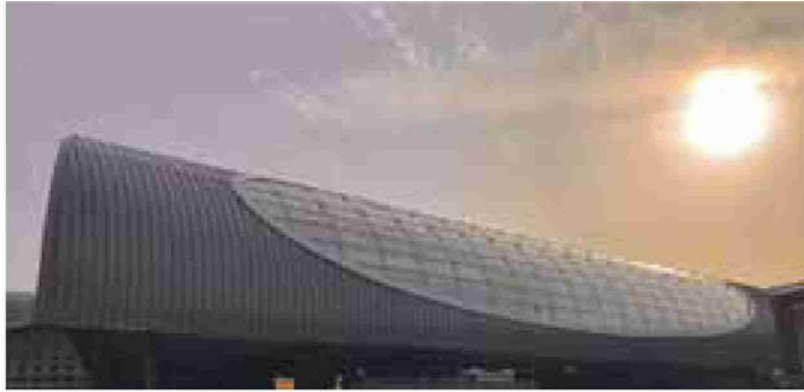
L'azienda friulana Simeon sta realizzando le facciate dei terminal T1 e T2 dell'aeroporto Charles De Gaulle, a Parigi
