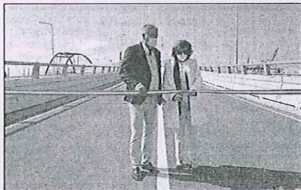
Il taglio del nastro dell'infrastruttura
