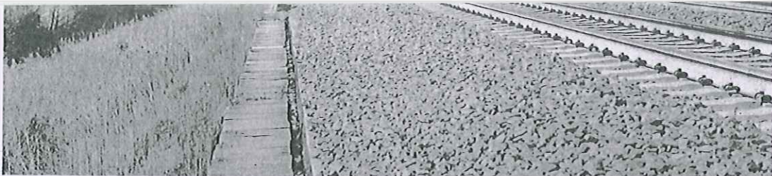
Ferrovie L'iniziativa di Oliverio punta a far costruire una linea ad Alta velocità da 300 Km/h e non la sola velocizzazione del tracciato esistente
