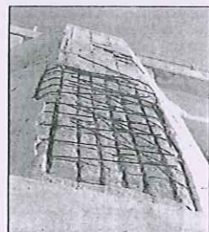
Le attuali condizioni della struttura in cemento armato
