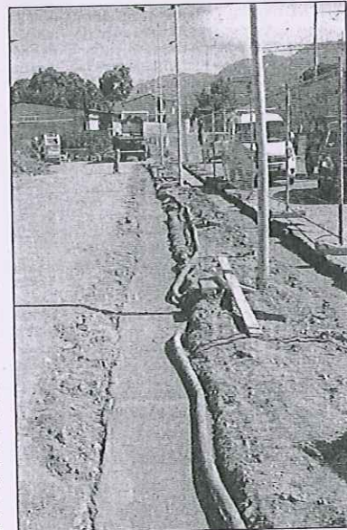
Alcune immagini del sopralluogo ai cantieri del progetto per il lungomare di Pellaro e del parco del Vento di Punta Pellaro
