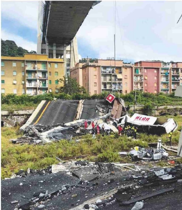
Genova Il 14 agosto 2018 il crollo del Ponte Morandi ha causato la morte di 43 persone FOTO LAPRESSE
