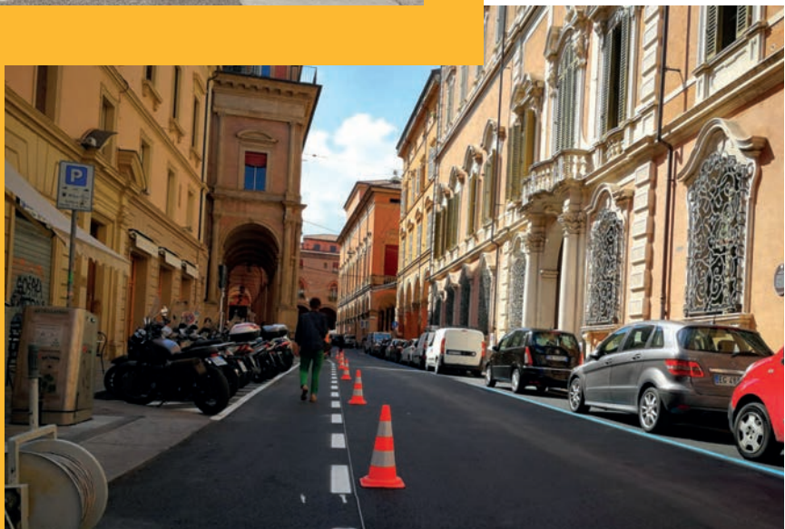
Lavori di realizzazione di ciclabile pop up a Ferrara (foto Comune di Ferrara)
