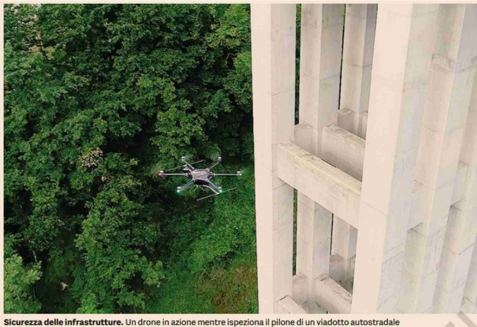
Sicurezza delle infrastrutture. Un drone in azione mentre ispeziona il pilone di un viadotto autostradale
