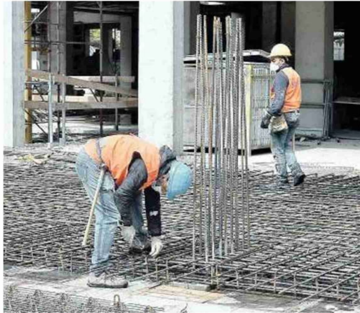
Operai al lavoro in un cantiere a Torino (foto ANSA)
