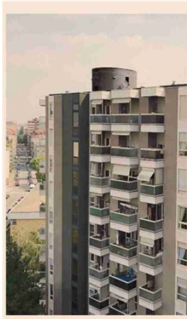
Torino. L'edificio che sarà riqualificato
