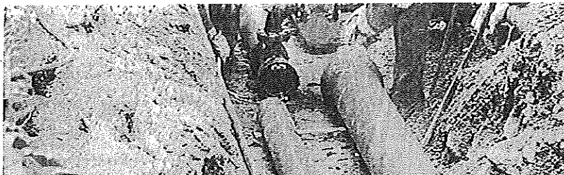
I lavori Gli interventi per la messa in esercizio ed il ripristino condotte idriche sono suddivisi in 5 lotti
