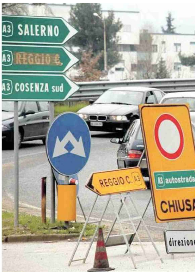
Cantieri sulla Salerno-Reggio Calabria (foto LAPRESSE) Sulla sinistra, il ministro per il Mezzogiorno Giuseppe Provenzano (foto MISTRULLI)
