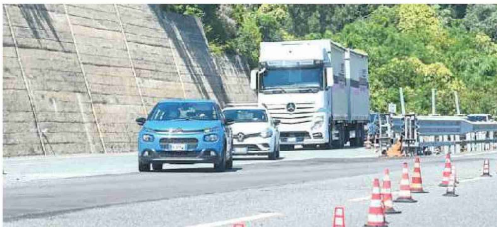
Una delle decine di chicane per passare da una corsia all'altra causa cantieri
