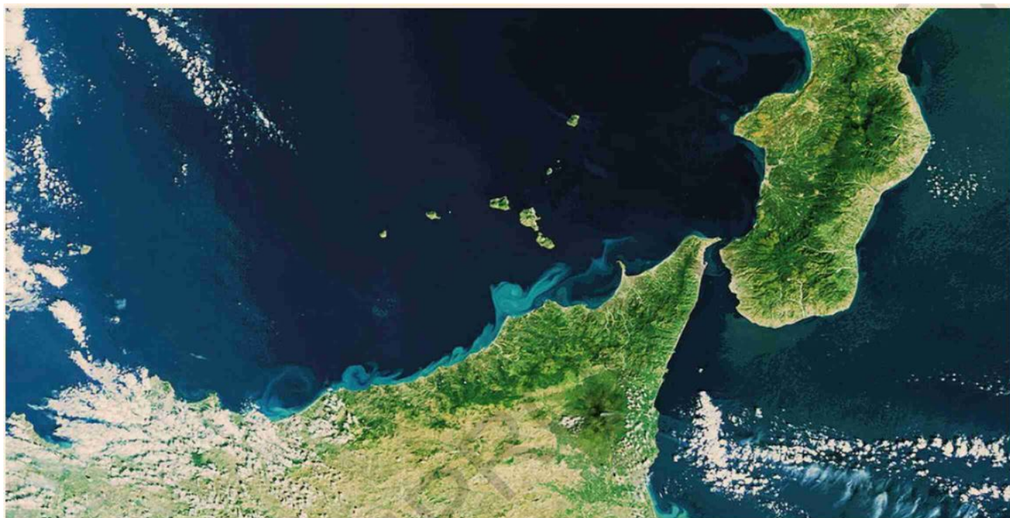
Grandi Infrastrutture. Una veduta dal satellite dello Stretto di Messina, tra Calabria e Sicilia, per il quale si torna a valutare il progetto di un collegamento stabile
