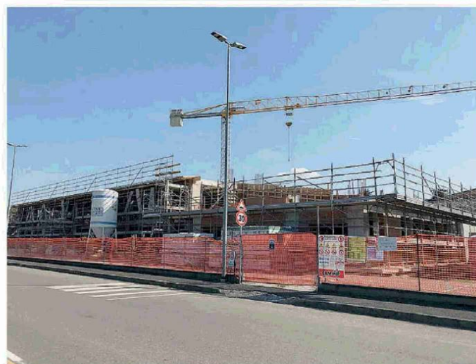
Uno dei cantieri in corso già ora è quello per la nuova scuola media di Cadeo
