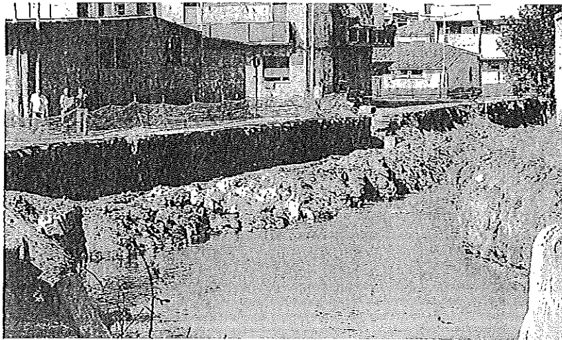
Fiume Budello. Stanno per ripartire i lavori per la sistemazione idraulica e la messa in sicurezza
