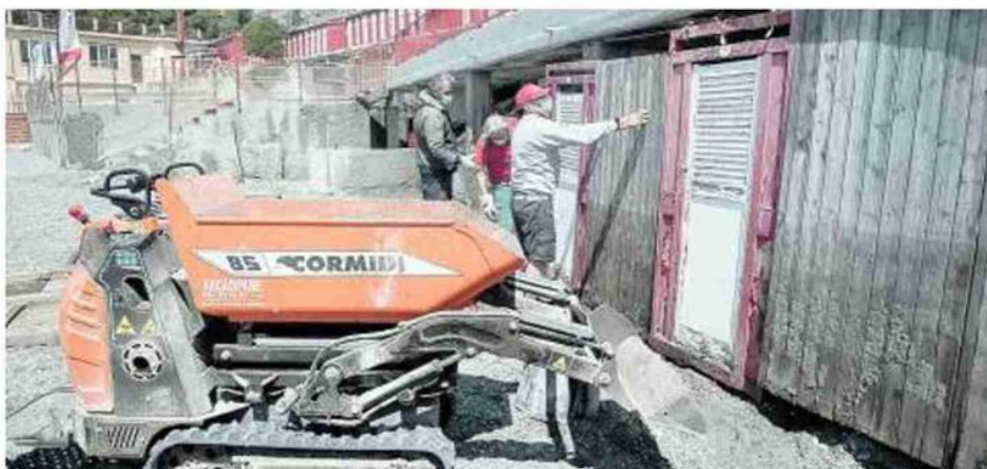
Lavori in corso sul litorale di Genova
