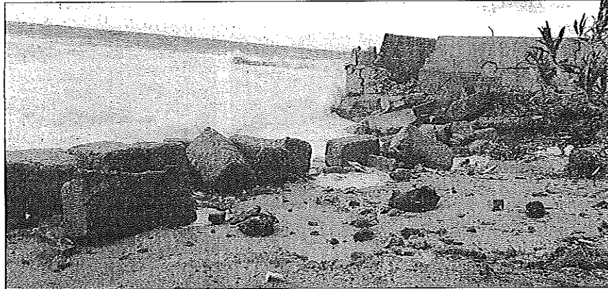
I danni causati dalle mareggiate a Favazzina
