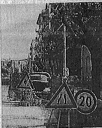
Locri I cantieri dei lavori di rifacimento dei marciapiedi di via Matteotti e di ristrutturazione del Mercato
