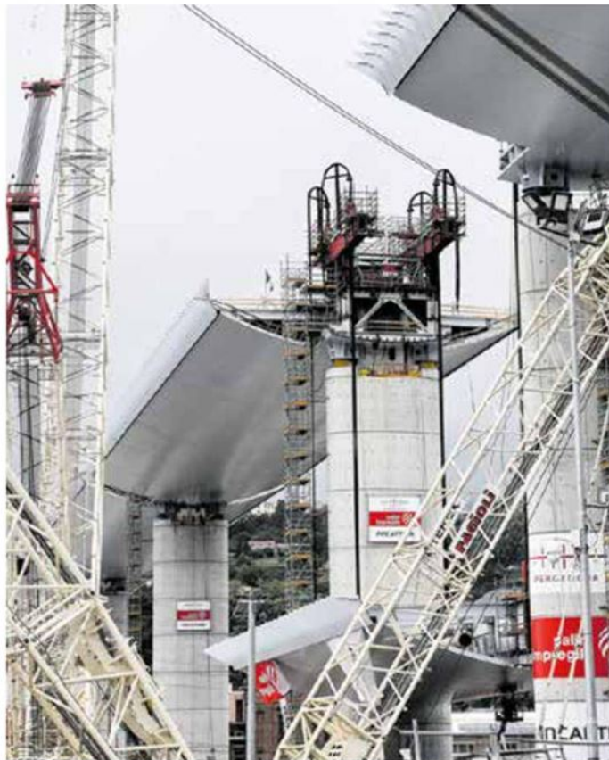
Genova, aprile, al lavoro sull'ultimo impalcato del ponte LaPresse
