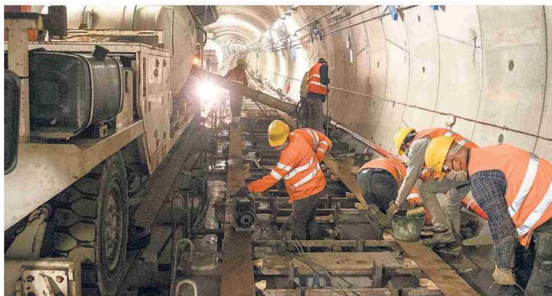
Il cantiere della metropolitana di Torino è stato riaperto a metà aprile. Anche qui gli operai devono seguire i protocolli per il contenimento del coronavirus
