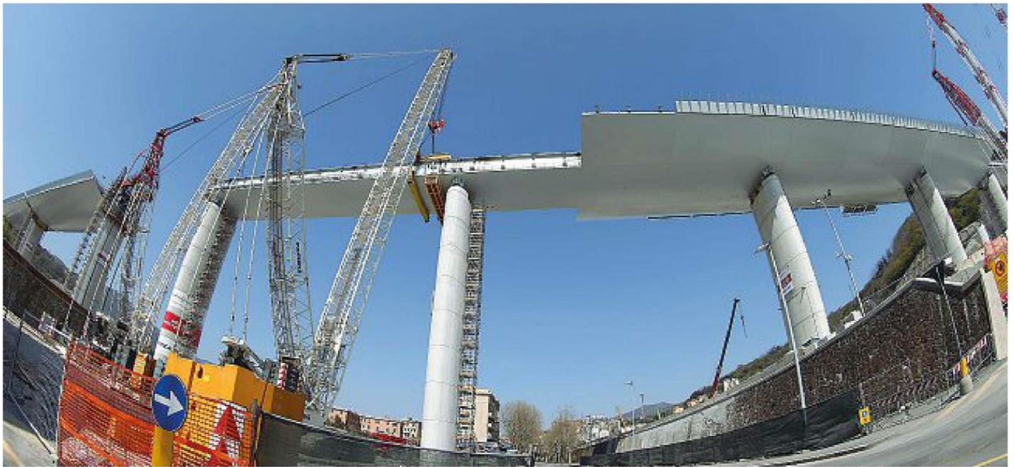
05/04/2020, Genova Cantiere del nuovo ponte di Genova, Varo della campata di 50 metri tra pile 12 e 13. Nella foto ultimato il posizionamento in quota della campata (fotografo: agf)
