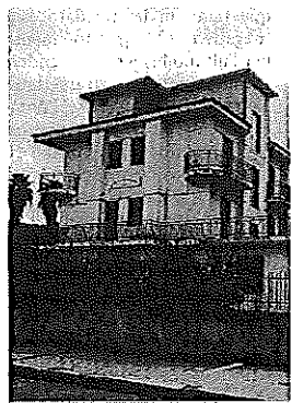
Verifiche Sopralluogo dell'Asp alla ex Rsa di Valleflorita
