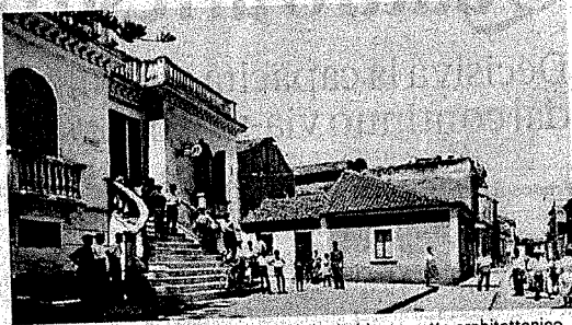
In cantiere Palazzo Foberti riprenderà il primitivo aspetto architettonico
