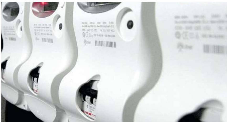
Ribassi in vista per elettricità e gas
