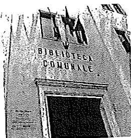
Lavori Gli interventi interesseranno anche la biblioteca comunale
