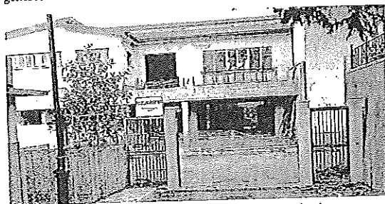
Scuola primaria Stanno per partire i lavori di messa in sicurezza
