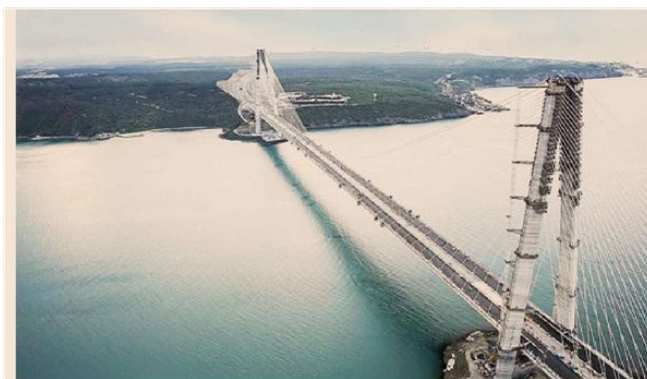
Terzo ponte sul Bosforo. Si attende a giorni il closing della vendita alla turca Ic Ictas Sanayi ve Ticaret da parte di Astaldi
