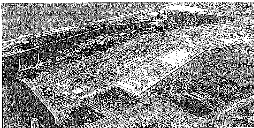
Porto di Gioia Tauro Oltre 16 milioni di euro per i lavori alla banchina di ponente lato nord
