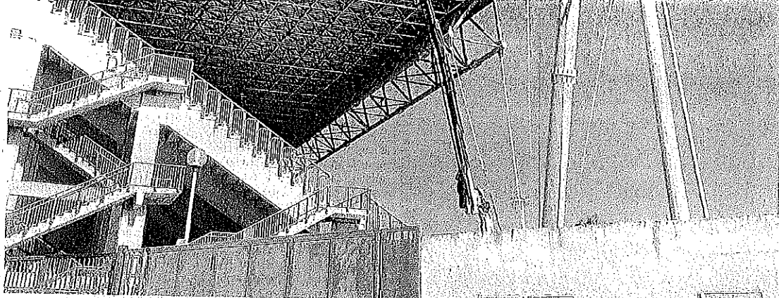
Tempi certi L'impresa sta certificando la tesatura dei cavi della Tribuna Ovest dello stadio "Oreste Granillo"
