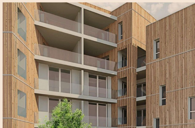
Casa Verde Noce. Un caso di demolizione e ricostruzione a Milano, che sfrutta al massimo i sistemi di pompe di calore
