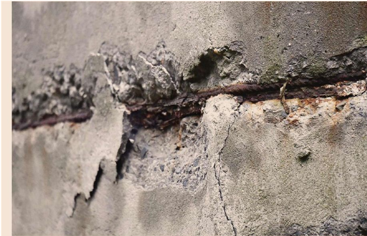
L'allarme ligure. Un particolare del viadotto della A6 sotto osservazione dei tecnici
