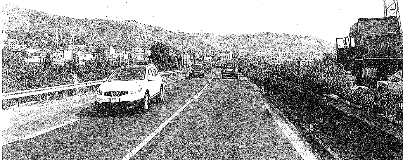
Demolito e ricostruito Il sovrappasso Savoia a Gallico presentava elementi di criticità e Anas è intervenuta nella primavera del 2015
