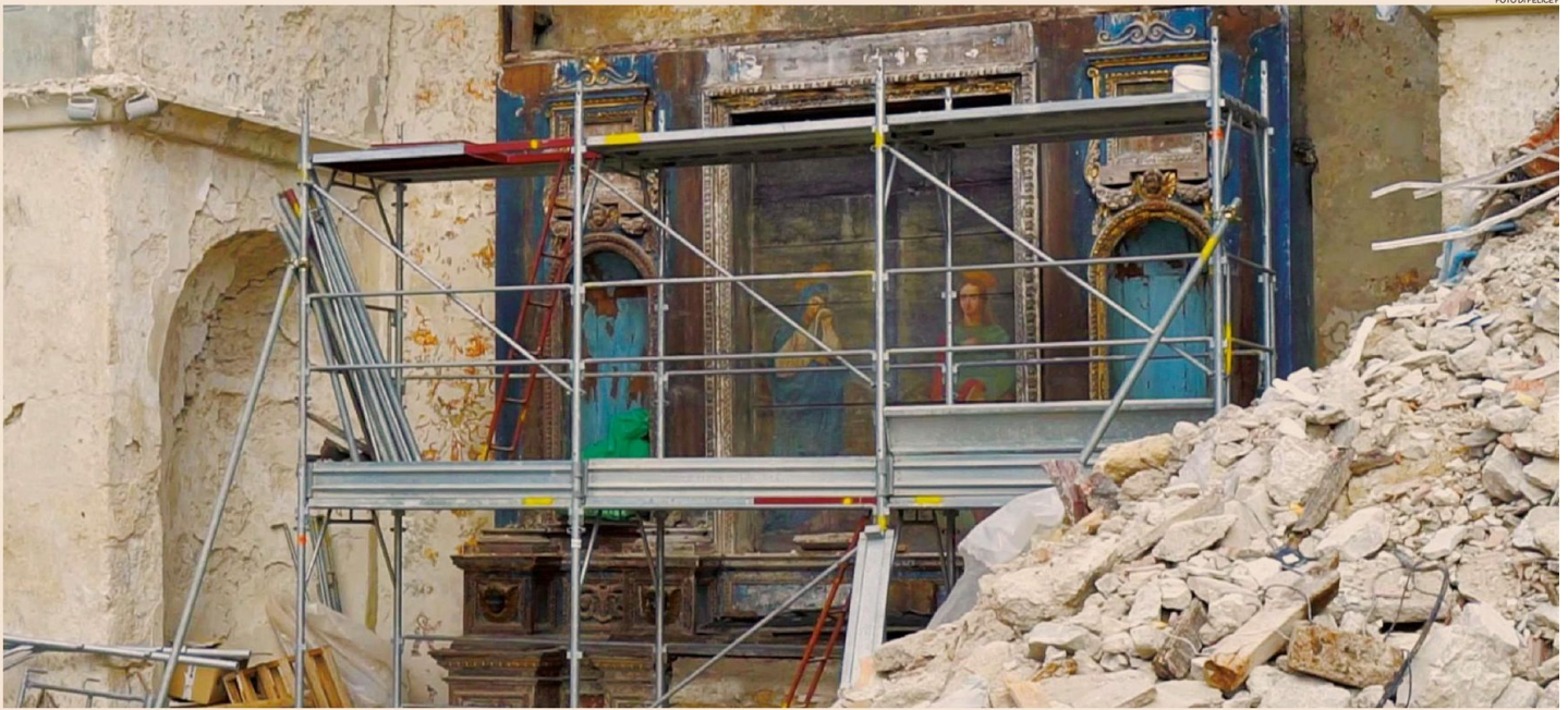
Castelluccio di Norcia. I lavori di recupero della Chiesa di Castelluccio, il 30 ottobre 2018. La frazione del comune di Norcia, in Umbria, è stata devastata dal sisma del 30 ottobre 2016
