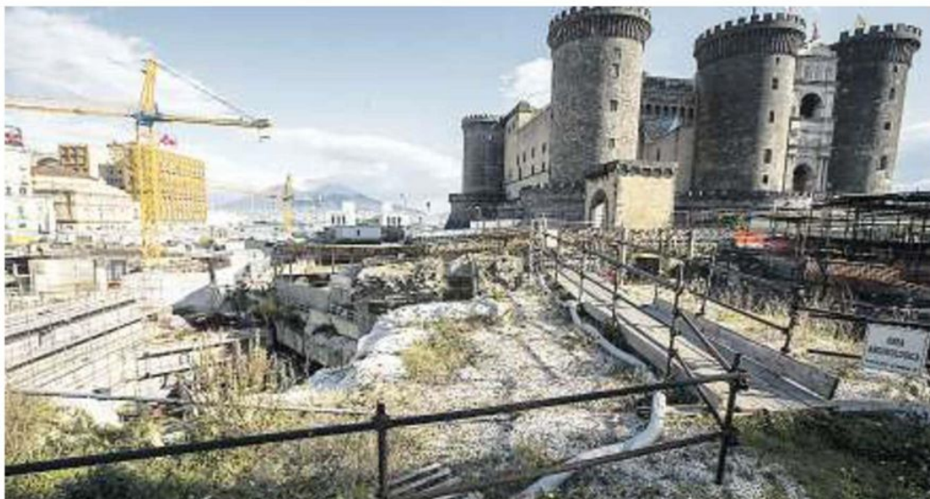
Il cantiere della metropolitana di Napoli, la principale opera in via di realizzazione con il contributo dei fondi europei
