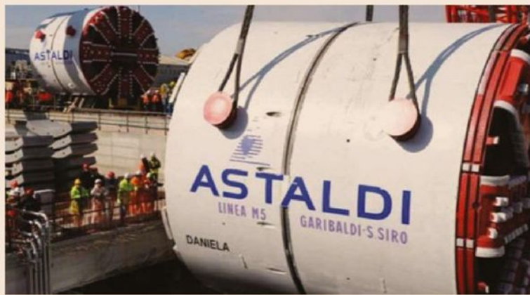
Grandi opere. Un cantiere di Astaldi
