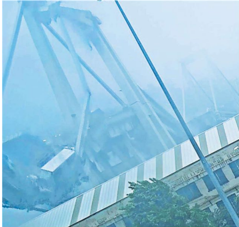
▲ Un fermo immagine del crollo del ponte
