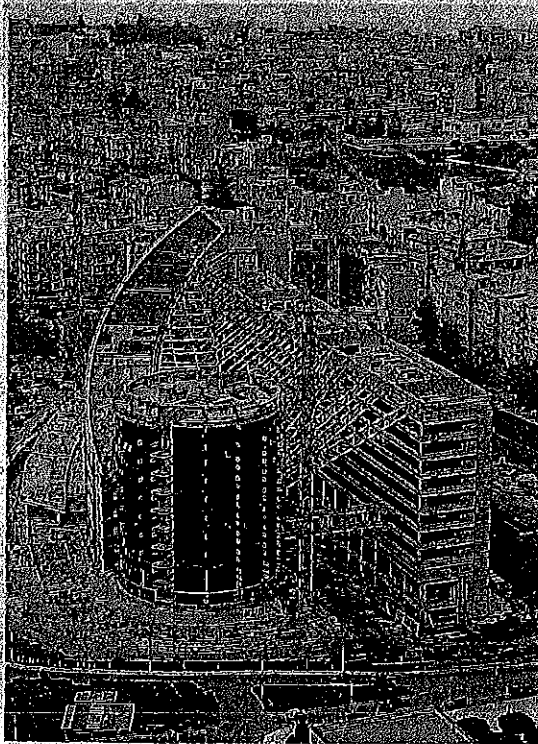
Incompiuta il nuovo Tribunale ancora non è stato completato.
