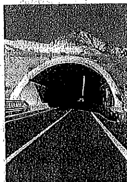
La nuova strada l'imbocco della galleria "Sant'Antonino"
