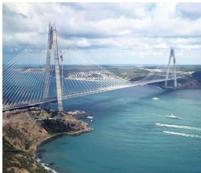
Il ponte sul Bosforo, uno dei progetti di Astaldi
