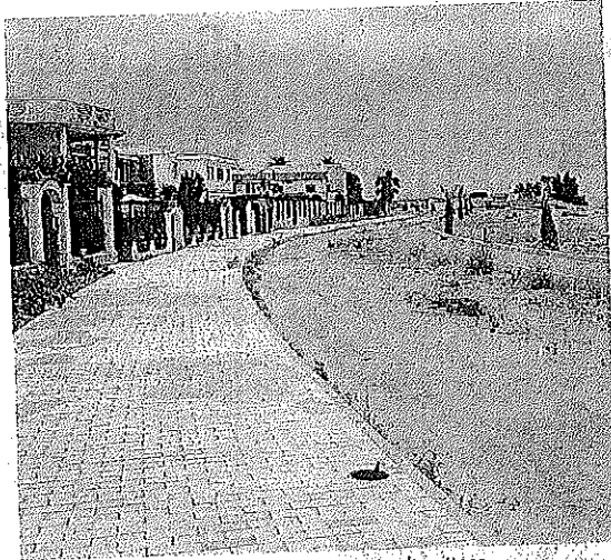
Cantiere Il Parco Lineare Sud è un'opera molto attesa
