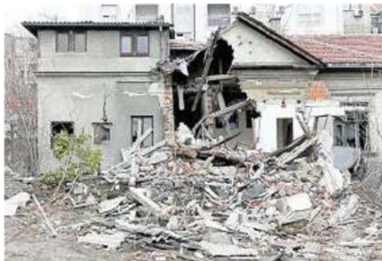
Una casa distrutta dal terremoto
