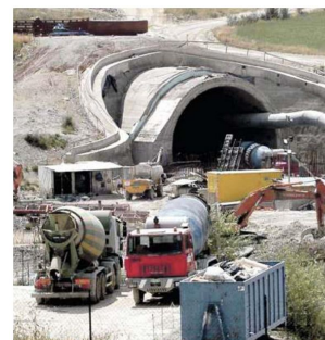
Uno dei pochi cantieri in attività in Italia
