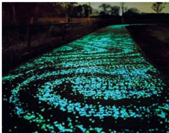
Calcestruzzo fotoluminescente / FOTO FEDERBETON
