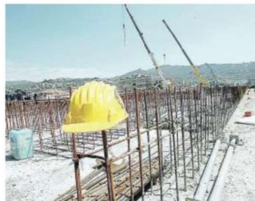
Lavori fermi in un cantiere autostradale
